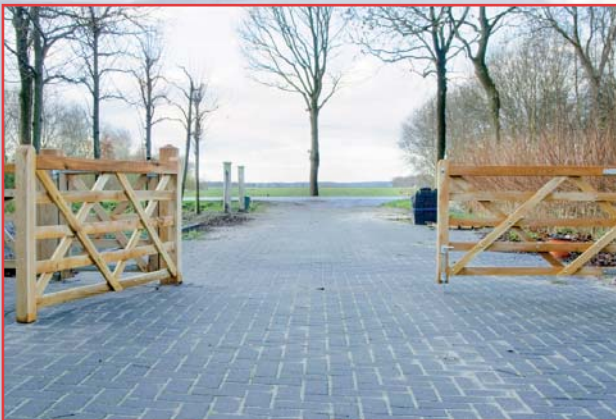
Hekwerk gemaakt en geplaatst
