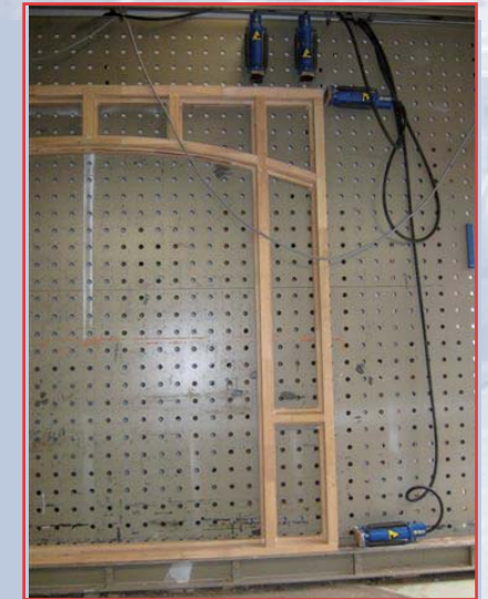
Maatwerk kozijn in de lijmpers
